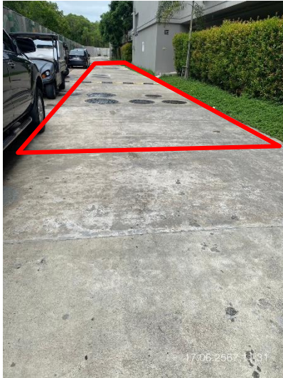
ภาพที่ 7 แสดงระบบบำบัดน้ำเสียส่วนกลาง(ใต้ทางวิ่ง)
