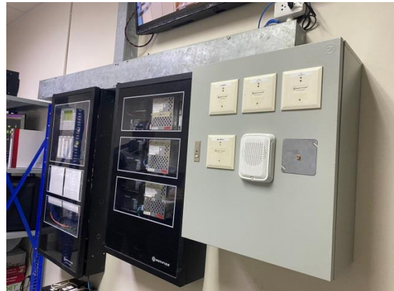
ภาพที่ 16 แสดงตู้ควบคุม/แผงควบคุมเพลิงไหม้
